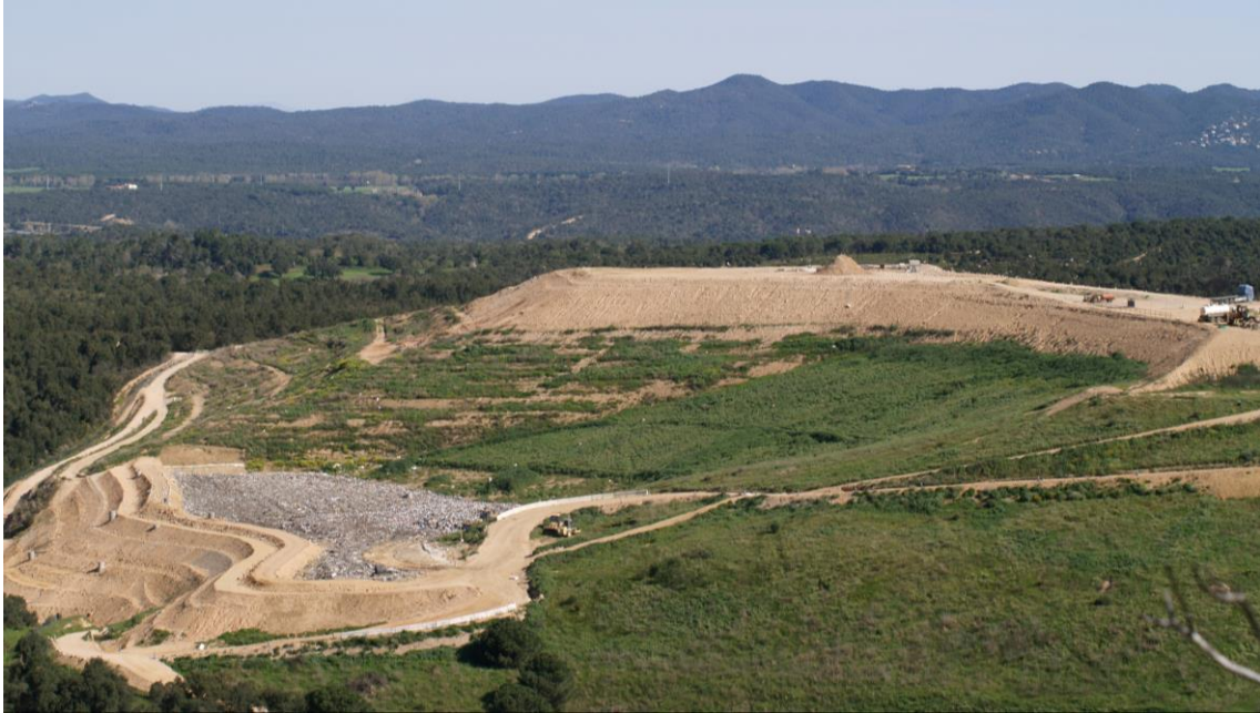
Figura 1. Imatge de l'abocador de Solius. Imatge presa des de un dels punts d'observació.
